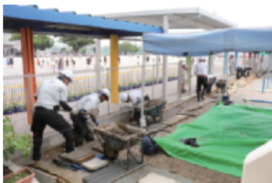
▲ こども園での作業の様子
