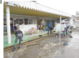
▲ 北保育園での作業の様子
