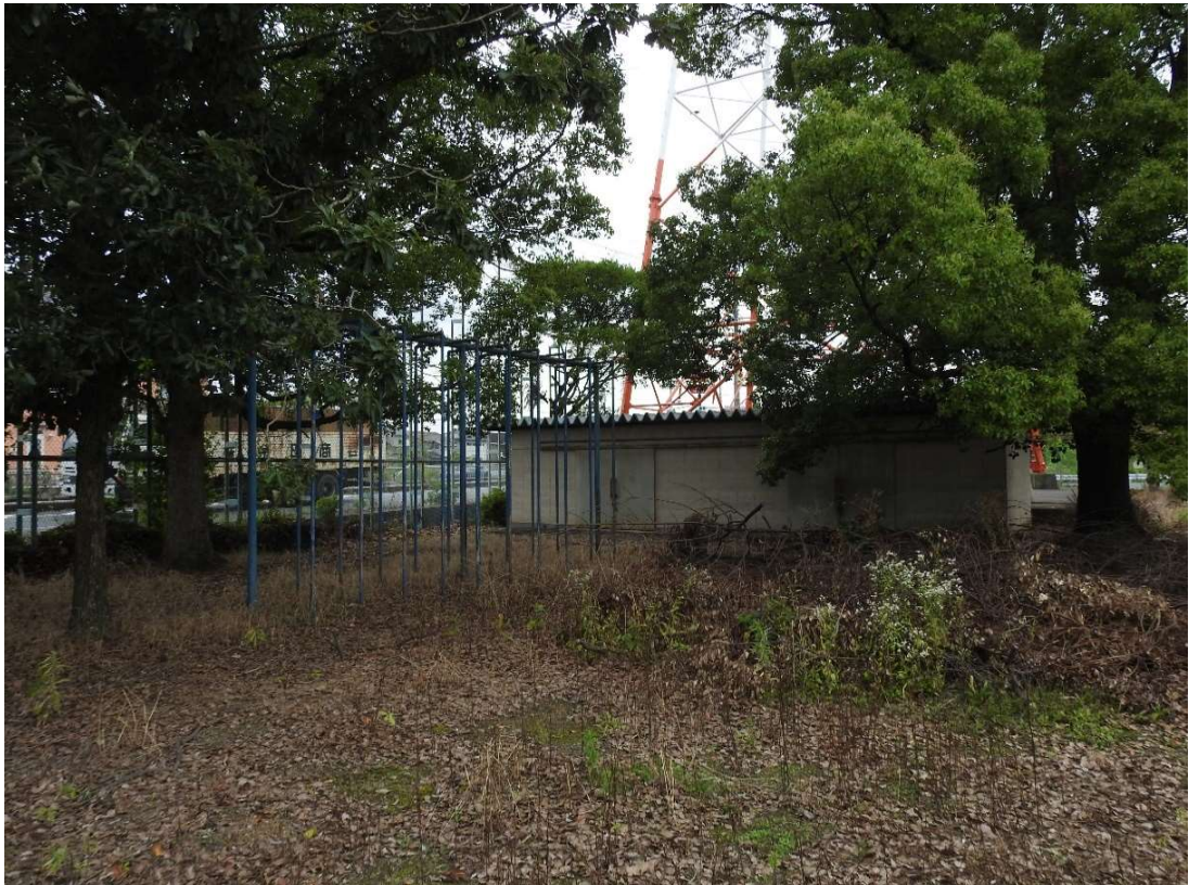
倉庫（グラウンド南）
