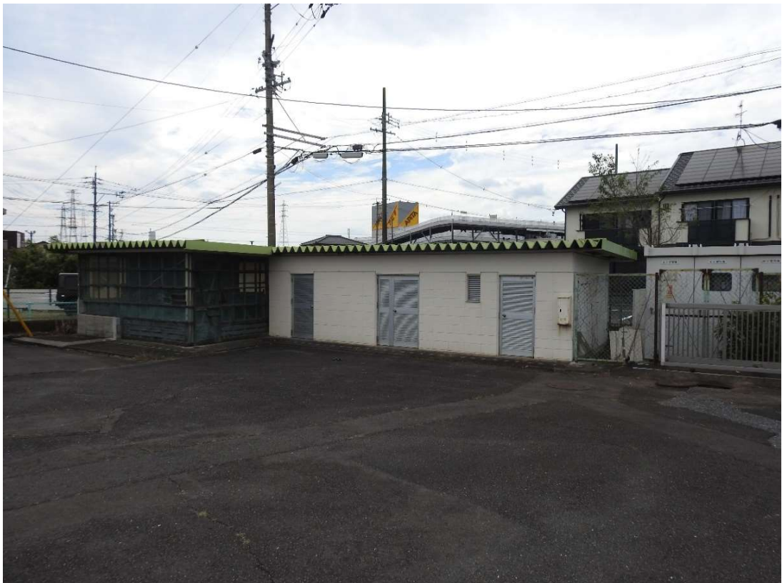
倉庫（敷地北西角）
