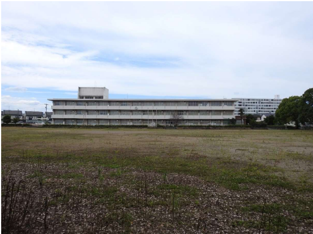
校舎を南から撮影
