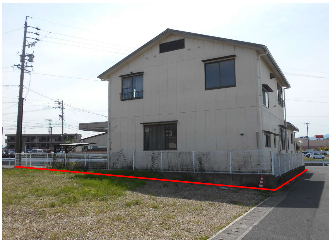
物件東方向から西方向を撮影
