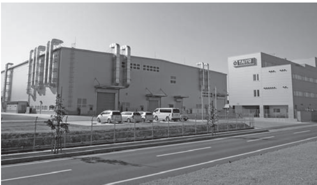
大洋電機(株)新社屋 (企業誘致エリア南工区)
